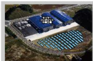
〈施設概要〉 設置容量：524kW 推定年間発電量：52.7万 kWh
